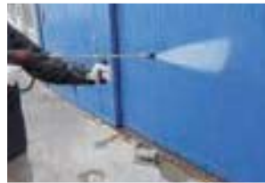
建築外壁洗浄
