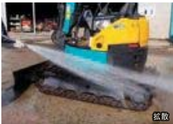
<VJ/WJの車輜、重機の泥土作業>
