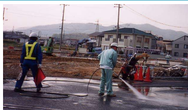
車輛・重機の泥土洗浄
