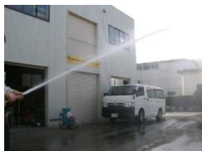
解体現場の防塵作業
